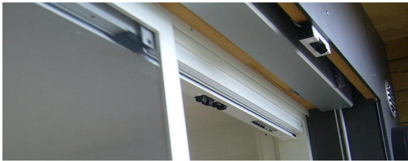
Antrieb zwischen einer Parallelschiebetür und Raffstore montiert
